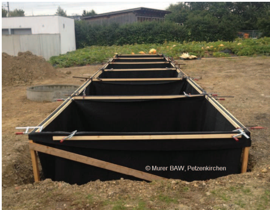
Abbildung 5: Lysimetergefäße der Lysimeteranlage Jägerhausgasse im Bauzustand.
