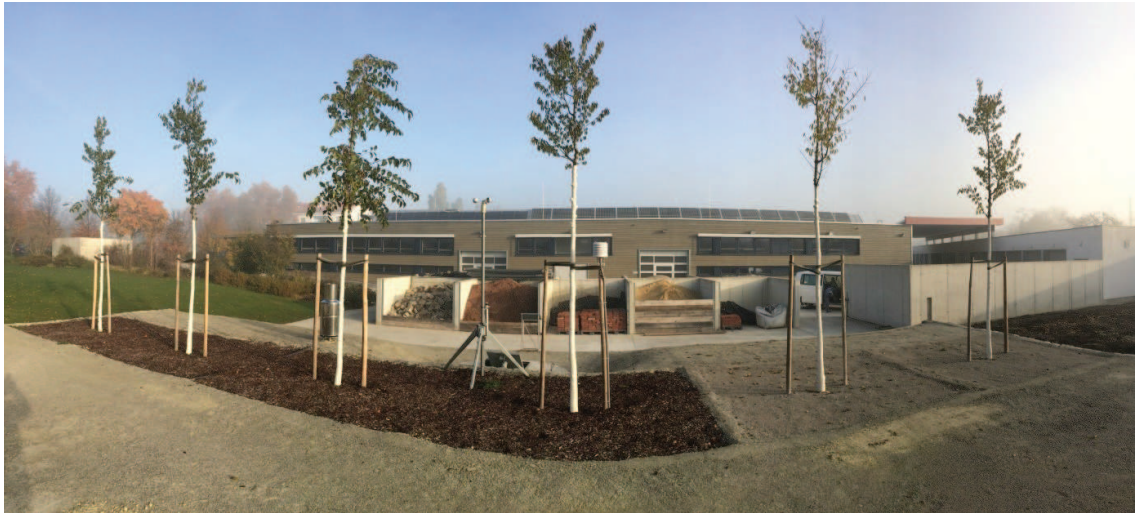
Abbildung 3: Baum-Lysimeteranlage Jägerhausgasse mit Celtis Australis .
