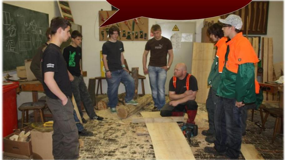
Zunächst produzierten wir Hocker in verschiedenen Formen. Herr FL Zeiner schnitt 40 Zentimeter-Stücke von einem Baumstamm ab. Anschließend wurde die Rinde mit einem Winkelschleifer und einer Fächerscheibe zum größten Teil entfernt. Einzelne verbliebene Rindenteile sorgten für einen urigen und natürlichen „Look“.
