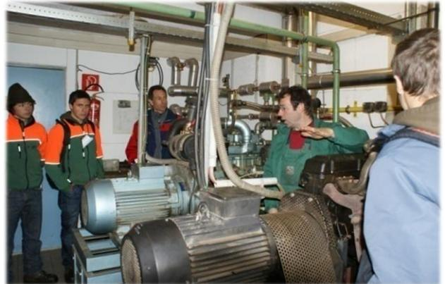
Zum Schluss konnten wir noch die Biogasanlage besichtigen, über die mit der anfallenden Gülle und Zusätzen Methangas erzeugt wird. Dieses betreibt je nach Bedarf einen selbst umgebauten Diesel- oder einen Ottomotor, die wiederum einen Generator zur Stromerzeugung bedienen. Zugleich wird die Abwärme genutzt und in das kleine Fernwärmenetz, das einige naheliegende Gebäude versorgt, eingespeist.
